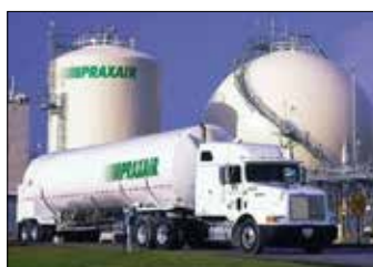
Завод Praxair, г. Волгоград
