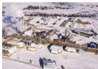
Нефтедобывающая станция TOTAL, Харьяга
