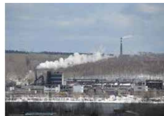
Завод Камтекс Химпром, г. Пермь
